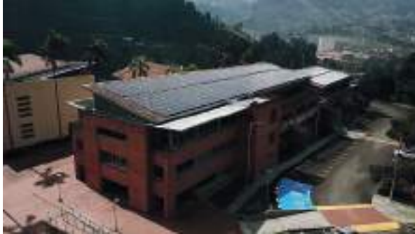
Paneles solares Clínica Veterinaria Lasallista
